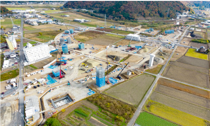
東海環状道 黒野地域近況 国土交通省提供 令和元年11月25日撮影
