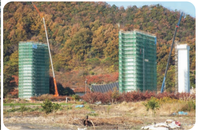
御望山トンネル東口橋脚(広報部写)
