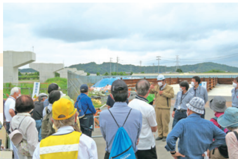
東海環状自動車道工事現場
